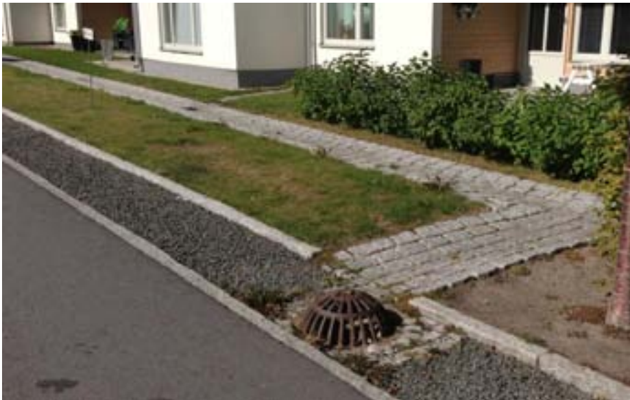
Figur 11. Exempel på infiltrationsstråk i urban miljö.
