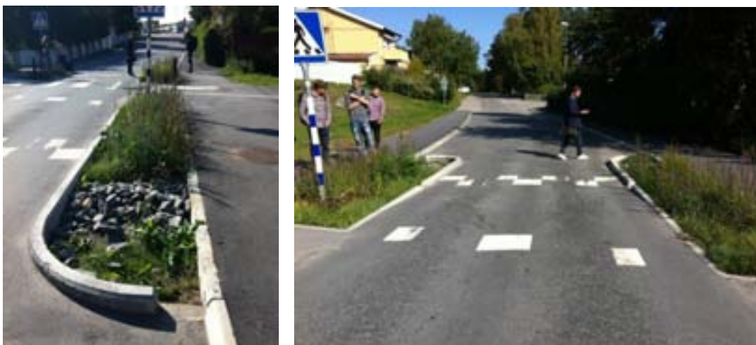
Figur 19. Växtbäddar som anlagts längst en trafikerad väg i form av farthinder vid en korsning och ett övergångsställe i Tyresö.
