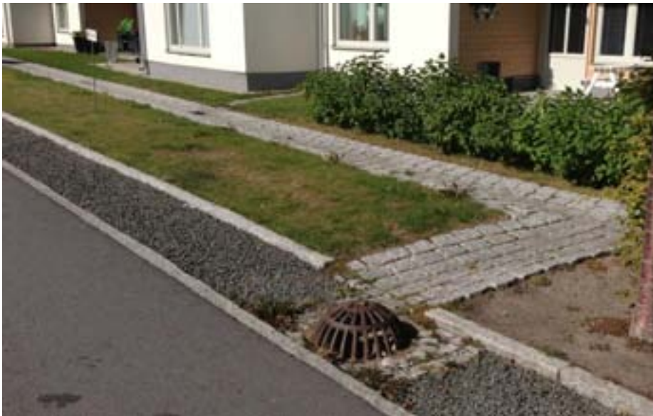
Figur 12. Exempel på infiltrationsstråk i urban miljö.
