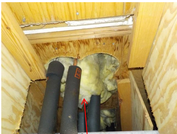
Otättheter runt rör genomföringar
