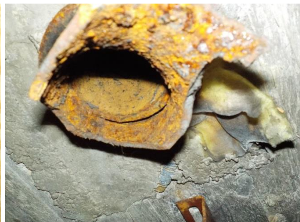
Gamla avslagna avlopp
