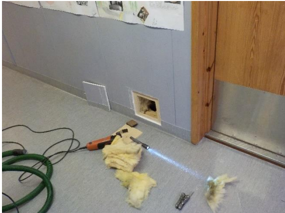
Inspektionshål PP1 i yttervägg
