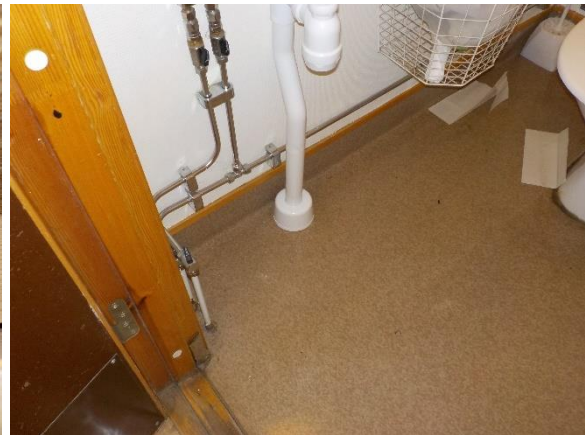
Mattsläpp runt tvättställsavlopp på golv i toalett
