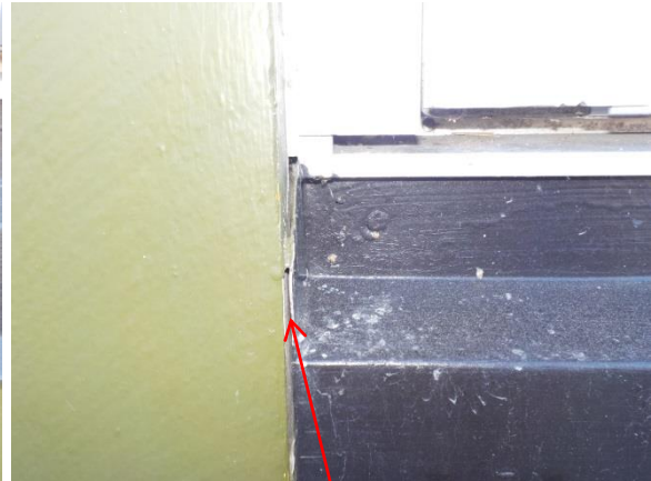
Otät bleckanslutning vid fönster
