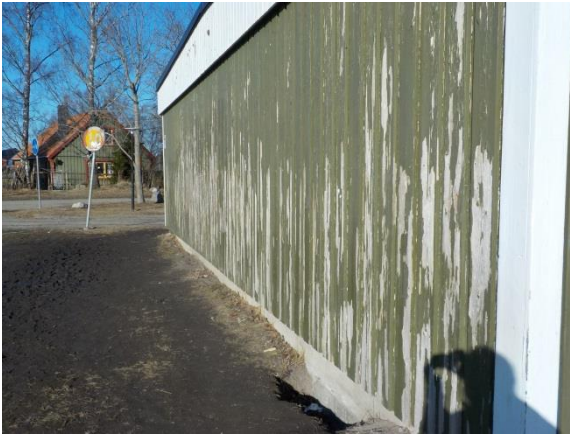
Färgsläpp samt dåligt underhåll av konstruktion
