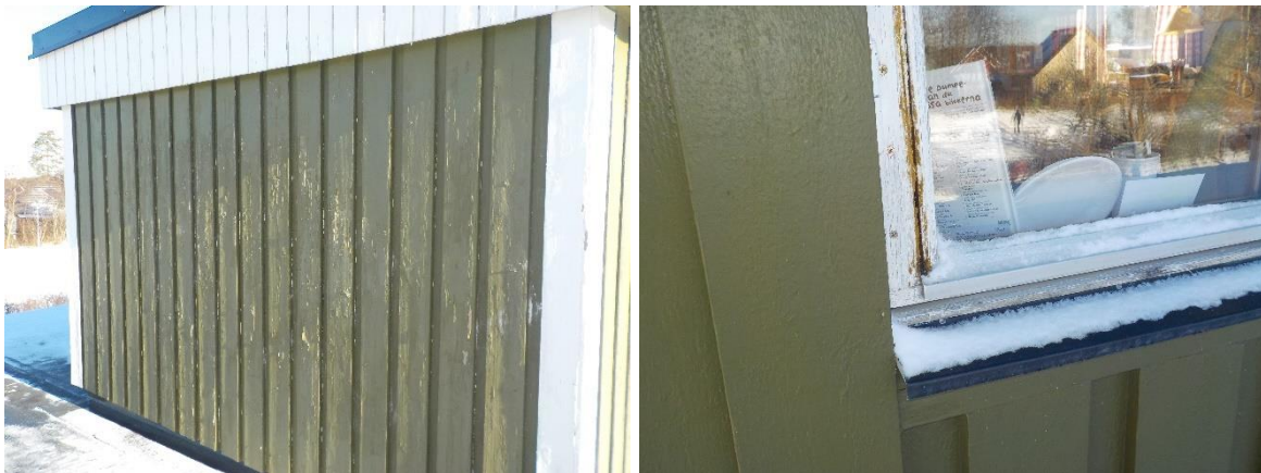
Färgsläpp samt murkna brädor
