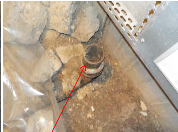
Gamla avslagna avlopp
