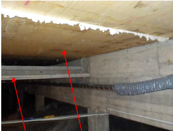
Betongbjälklag samt träbjälklag med stålbalkar
