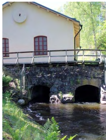
Uddby kraftverk i Tyresåns utlopp uppfördes år 1898.
