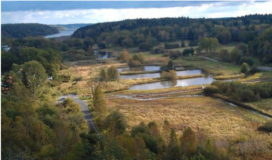
Flemingsbergsvikens våtmarksanläggning nordväst om Orlången.
