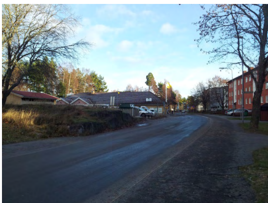
Vy längs Ringvägen. Fastigheten till vänster.
