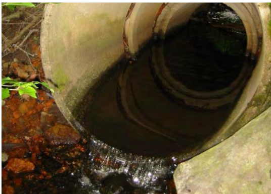
Ett exempel på en för högt monterad trumma där fisk har svårt att ta sig upp.
