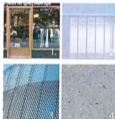
1. Mässingplåt ovan butik och bostadsentréer 2. Genomsiktig fasad med bakomliggande fönsterpartier. 3. Perforerad plåt med bakomliggande glas täcker sockelbyggnadens övre del. 4. En bas av betong lik sockelvåning i kv 02.
