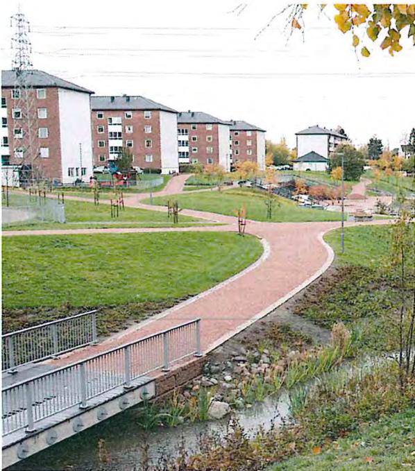
Dagvattenanläggning i bostadsområde som kan fungera som översvämningsyta vid extrema regn, Oslo. Foto: Sweco
