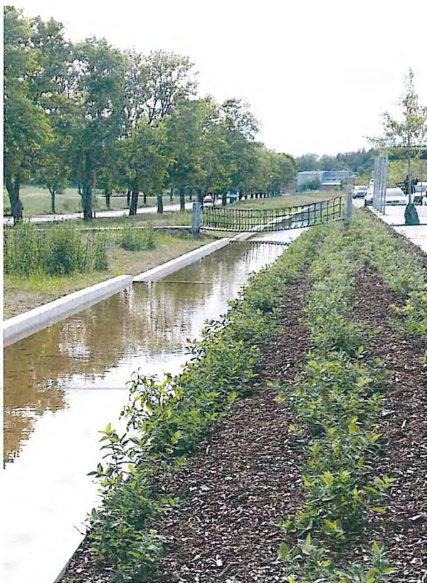
Robust dagvattenhantering i Ultuna, Uppsala. Foto: Sweco
