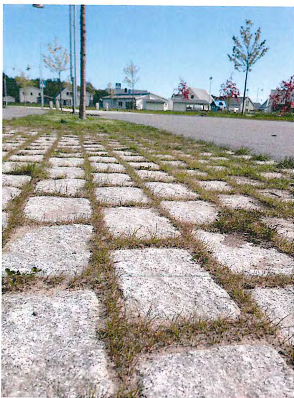
Infiltrationsgenomsläpplig yta i Nedersta bidrar till grundvattenbildning. Foto: Torbjörn Boström
