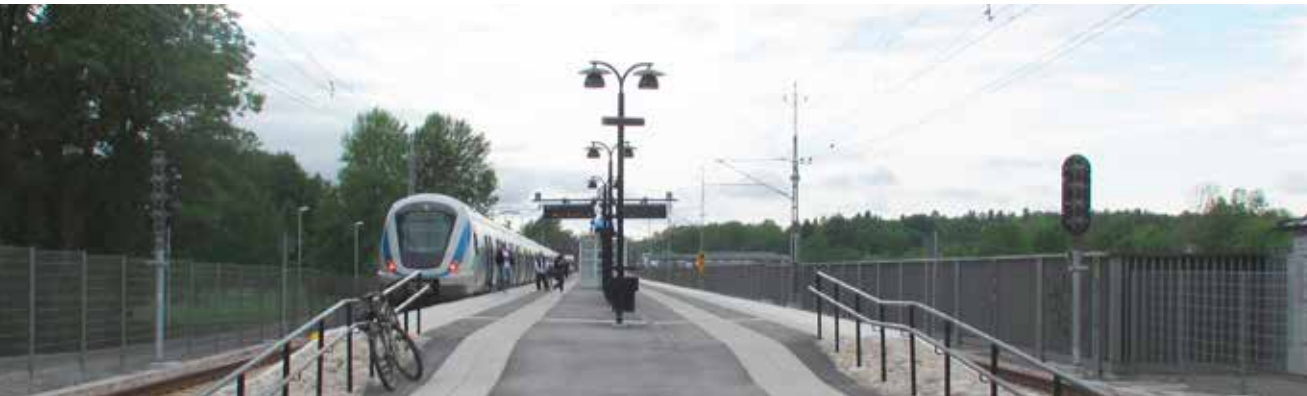
Pendeltågsstationen i Krigslida. Foto: Trafikverket
