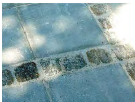
Golv med betongplattor med inslag av natursten
