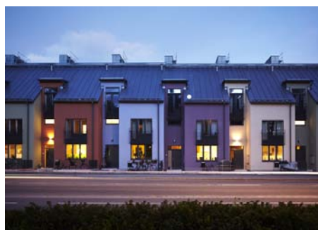
Varierad radhusbebyggelse. Exempel kv Mursmäckan, Kärntorp
