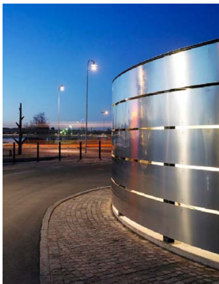
Transformatorstation. Exempel Jönköping
