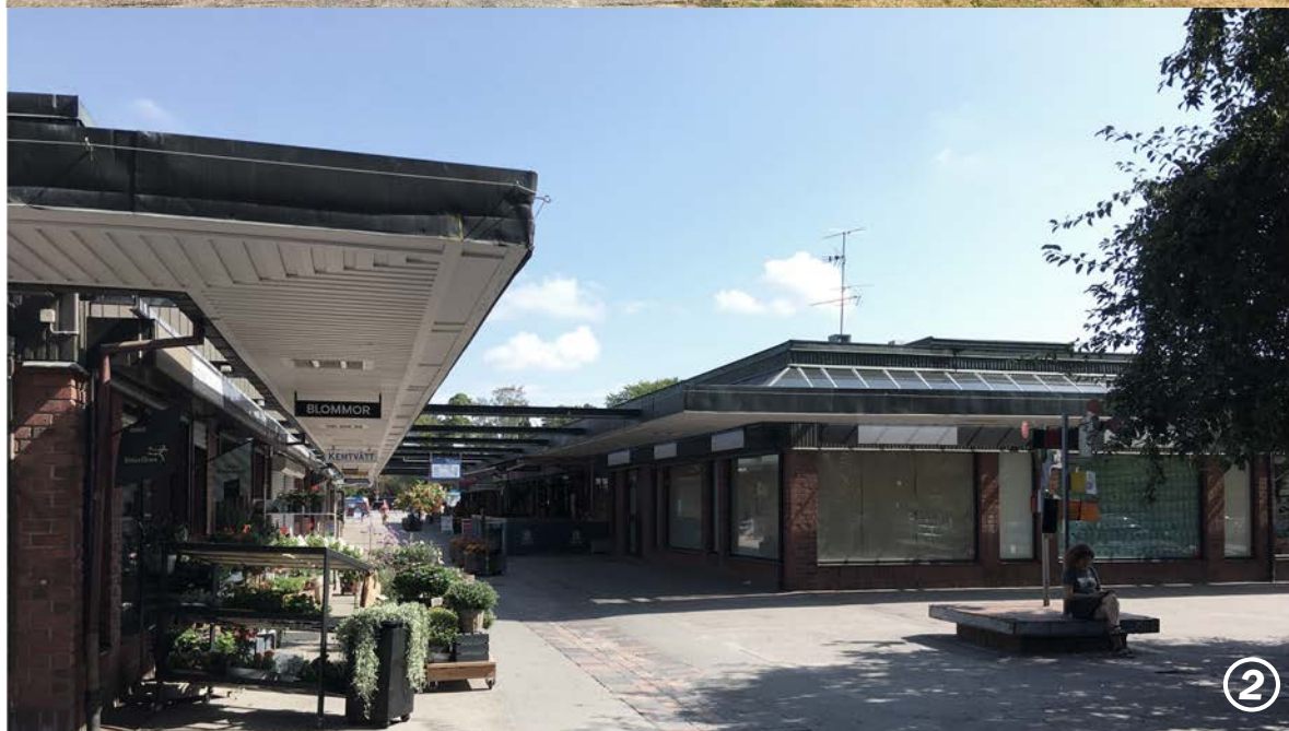
1. Gamla kommunhuset, 2. Centrumbebyggelse. Foto: Haninge kommun.
