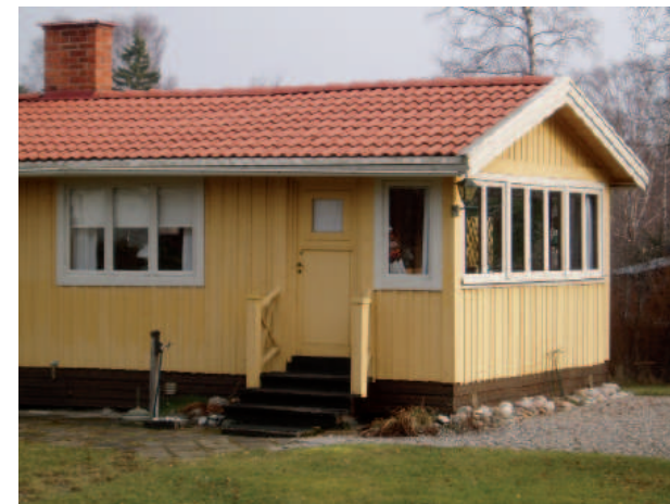
Fönstrens placering är viktig. I Årsta havsbad har det blivit ett karaktärsdrag med fönster över hörn och på gavlar när kvistar och verandor har byggts in. Fönsterna är enkla och ospröjsade.
