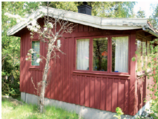
Att måla foder och knutar i samma färg som resten av fasaden är tradition i Årsta hasvbad
