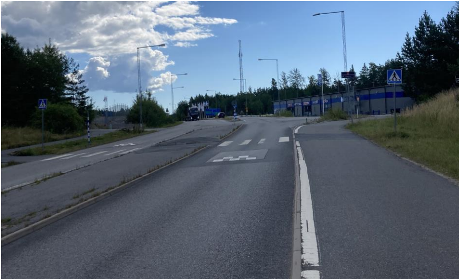
Figur 10 Korsning väg 563 och väg 560 sedd från väster (Sweco, 08-2022)
