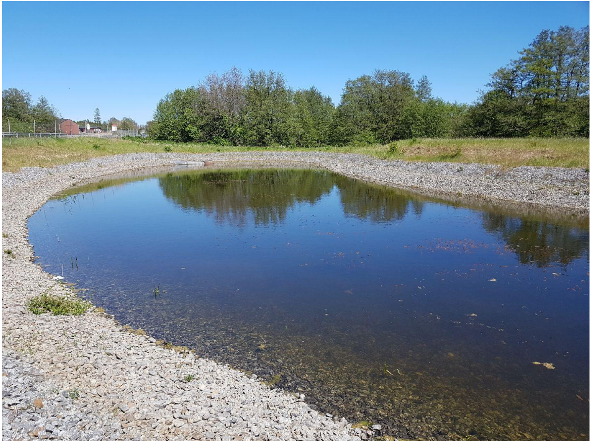
Trafikverkets damm, damm nr 3.
