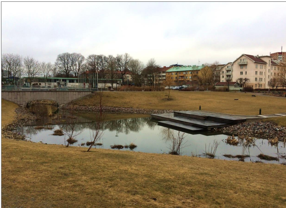
Figur 7-3. Exempelbild av en dagvattendamm i Stockholm. Foto: Geosigma.
