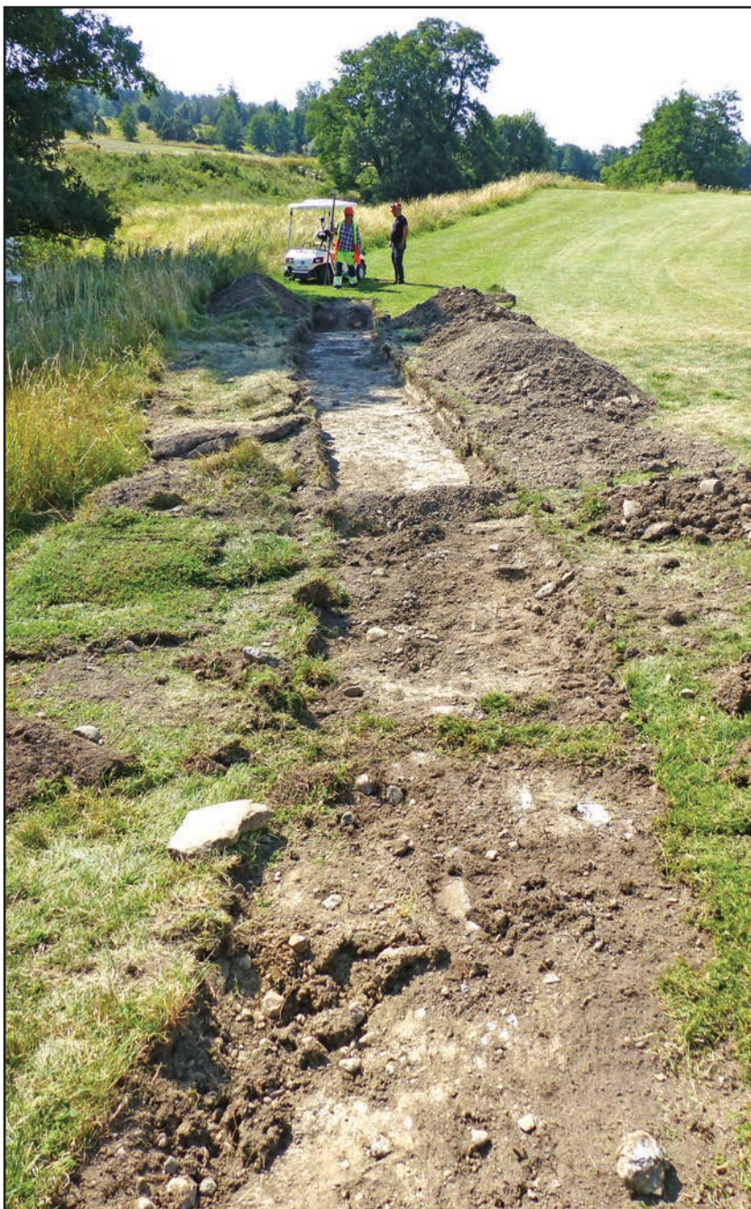
Fig. 13. Objekt 20, plats för en bro över Vitsån. I schaktet, hitåt i bilden, noterades en äldre vägbana i form av hårdpackat grus. Vid metalledetektering framkom två hästbroddar. I övrigt noterades rester av betongfundament, i slänten ner mot ån samt några större stenblock i kanten av ån. De senare kan vara rester av någon äldre konstruktion.. Det bedöms inte finnas något av antikvariskt intresse i området. Vy från öster.
