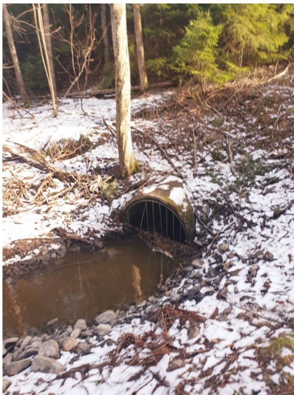
Figur 33. Bild på Åbyån och trumman som leder vattnet under Nynäsvägen och Nynäsbanan
