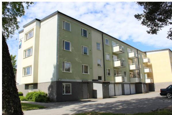
Fastigheten på andra sidan Ringvägen: Parkering i garage i markplan samt på kvartersmark.
