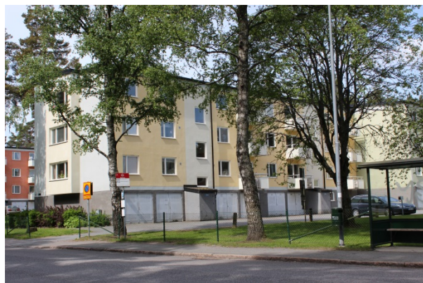
Befintlig bebyggelse vid Ringvägen
