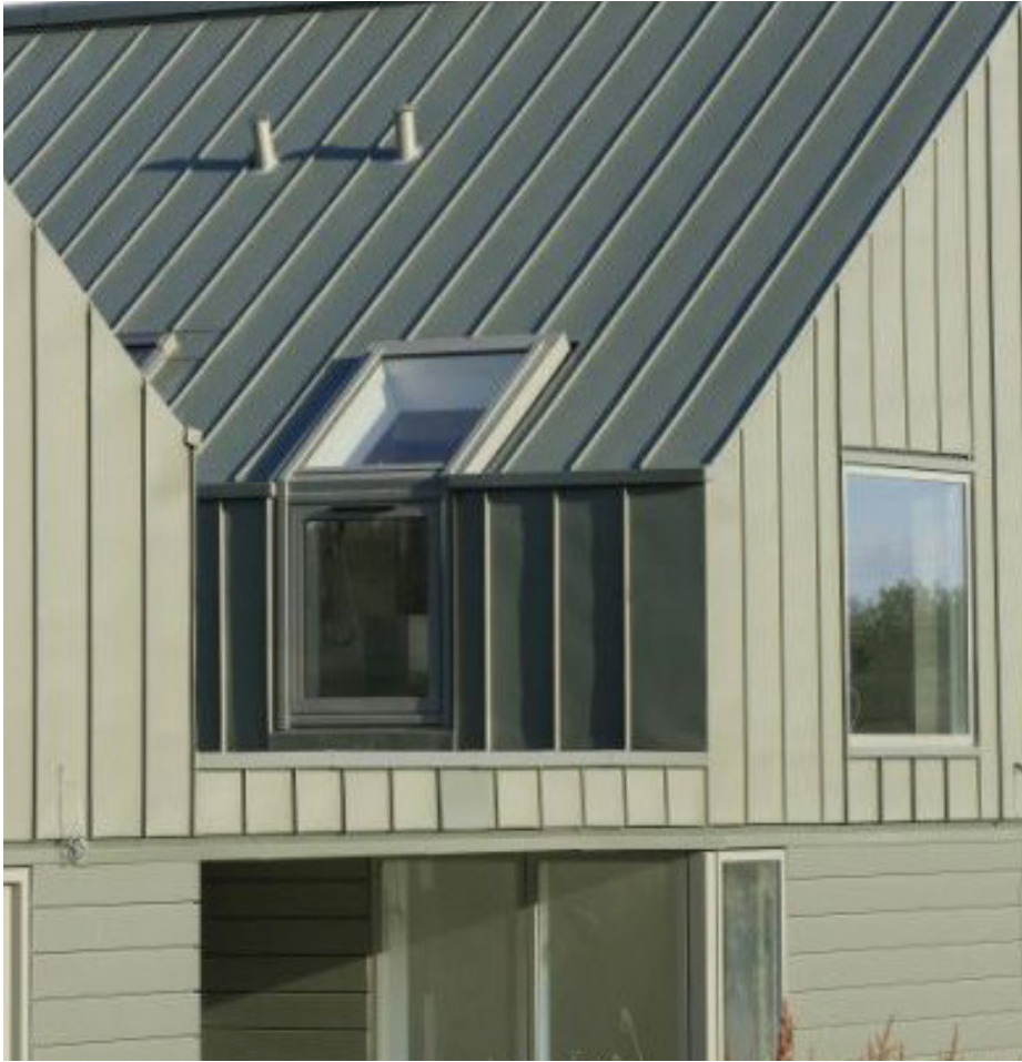
Ateljéfönster som binder ihop fasad och tak
