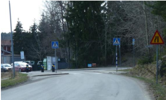
Fartdämpande åtgärd på Järnåldersringen
