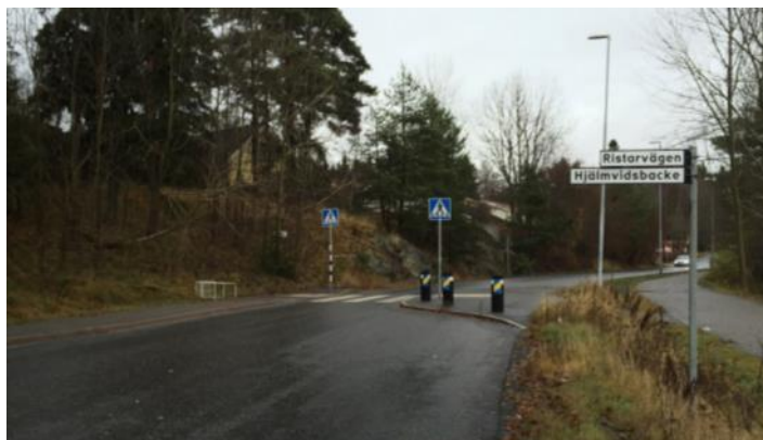
Nuvarande avsmalning på korsningen Järnåldersringen-Ristarvägen
