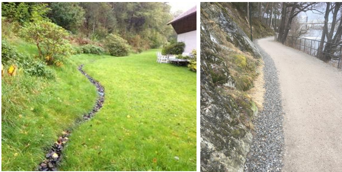
Figur 14. Exempel på avskärande diken för att bromsa naturmarksavrinnig.
