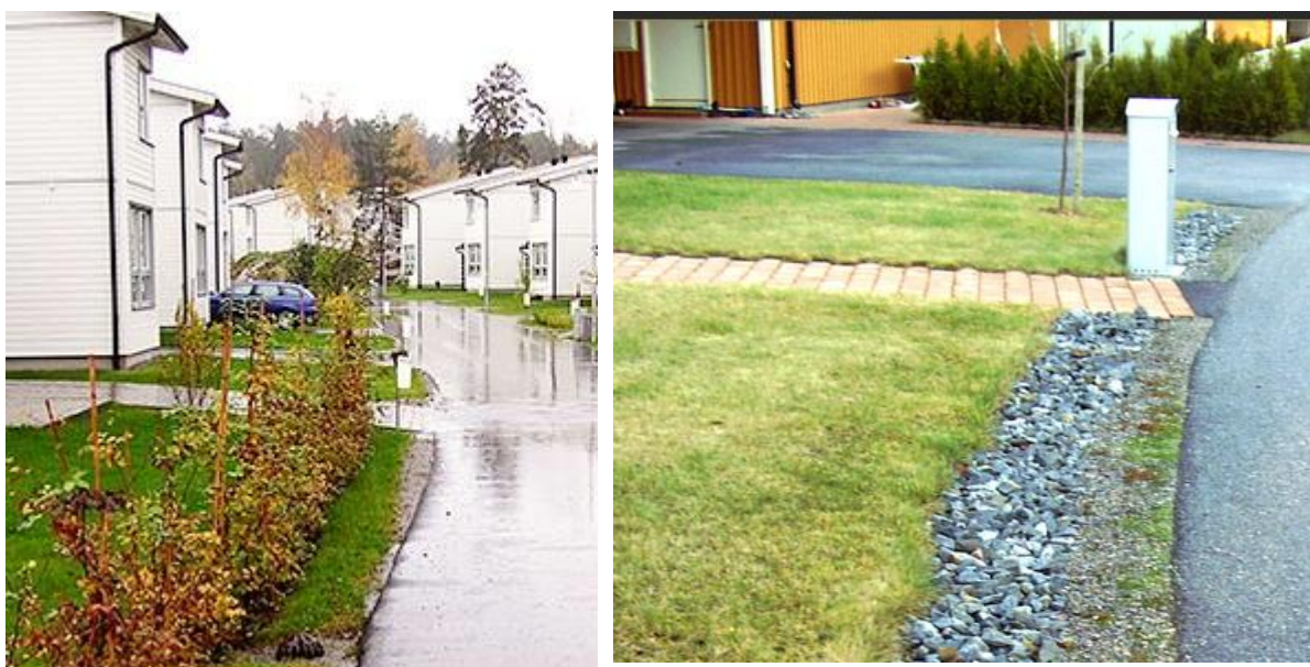
Figur 13. Exempel på dräneringsstråk i villaområden med lokalgator.
