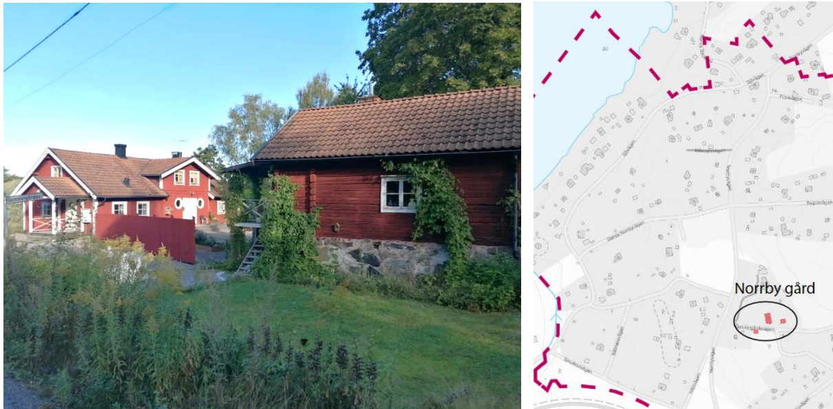
Bild 9. Bevarade byggnader vid gården Opp-Norrby, uppförda omkring 1850.
