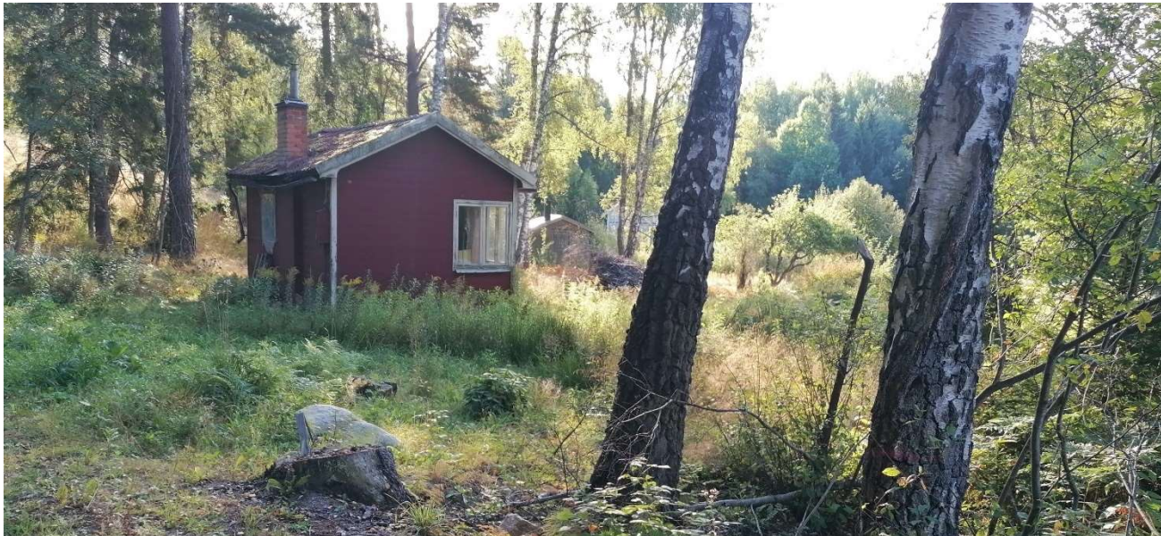
Figur 6-1: Byggnad som till synes verkar vara övergiven.
