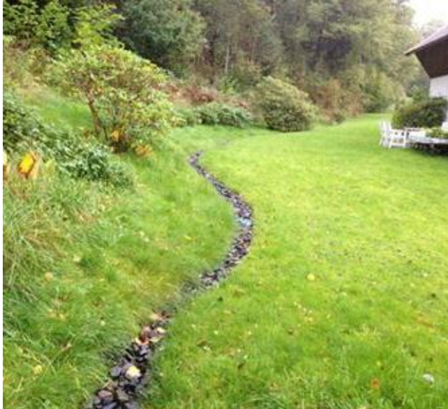
Figur 14. Exempel på avskärande diken för att bromsa naturmarksavrinnig.
