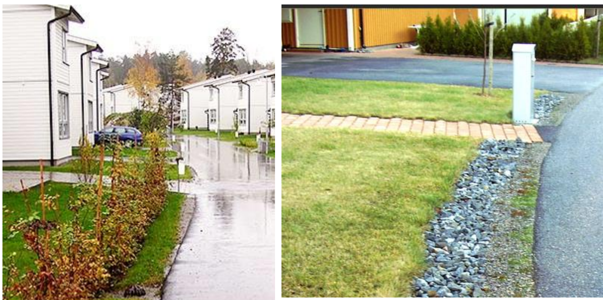
Figur 13. Exempel på dräneringsstråk i villaområden med lokalgator.
