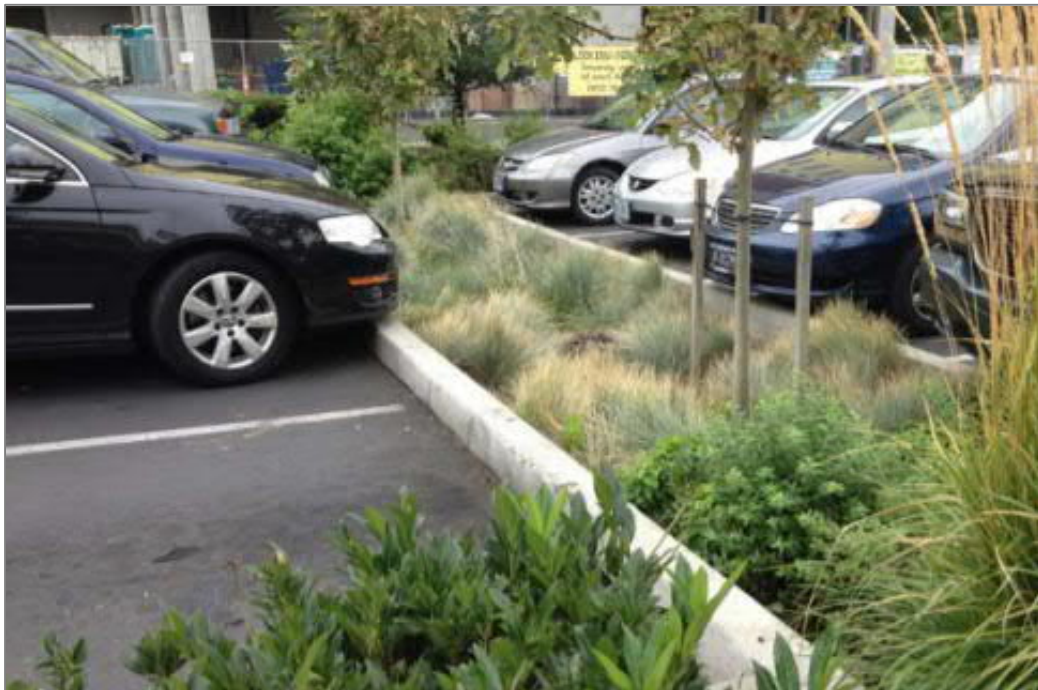
Figur 7-4 Exempelbild på en nedsänkt växtbädd intill en parkering (Stockholm Vatten och Avfall, 2019).
