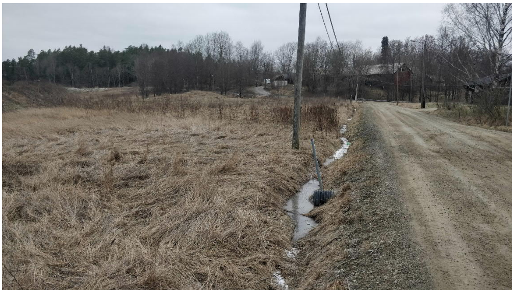
Figur 4-1 Fotografi längs med Smultronvägen i västlig riktning mot korsning med Gamla Norrbyvägen. Även tvärs över Smultronvägen avleds vatten söderut genom kulvertar.
