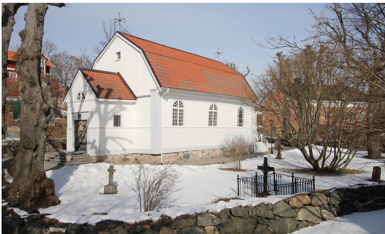
NEDAN: KYRKAN I FÖRGRUNDEN, TULLHUSET BAKOM TILL HÖGER
