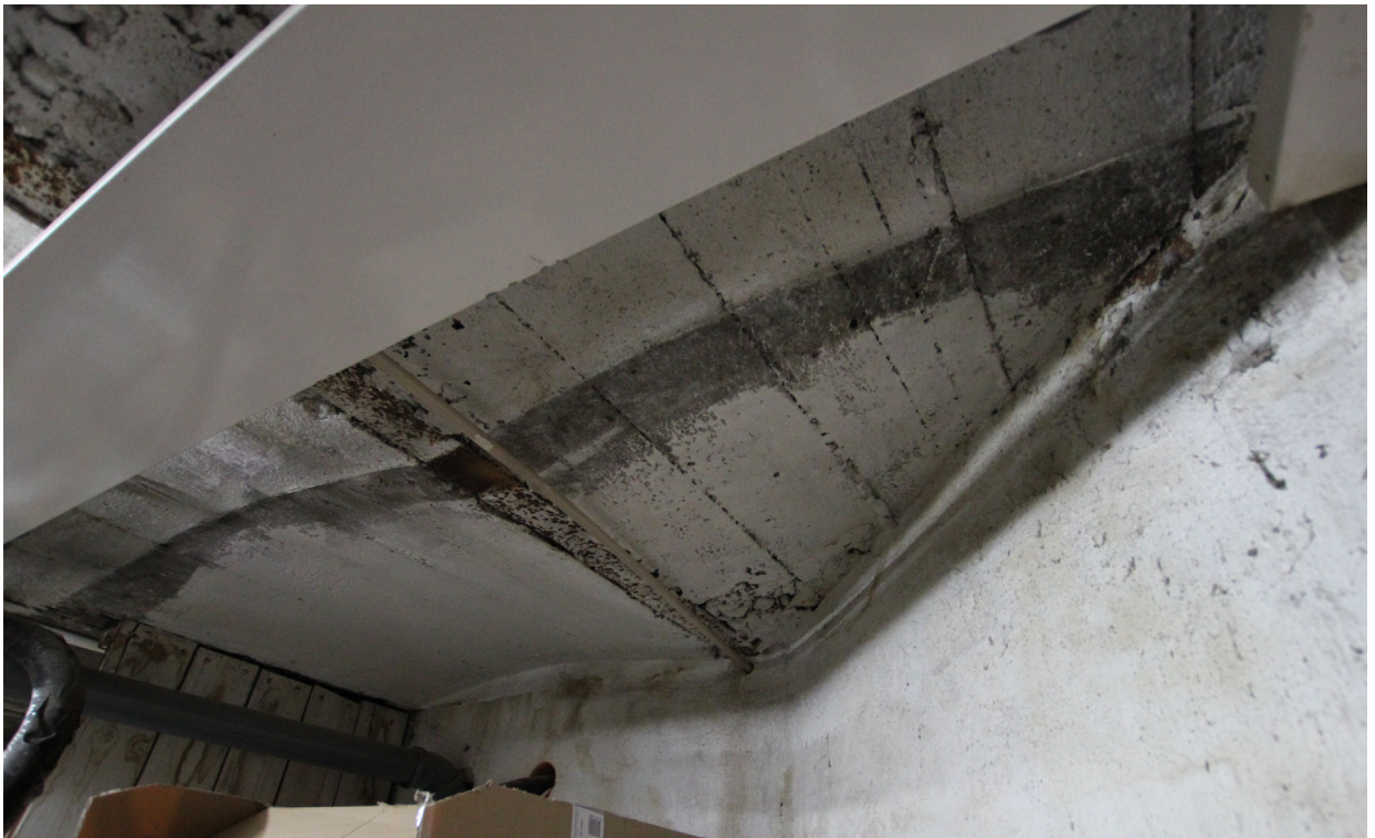
KÄLLARENS STICKVALV I BETONG MELLAN JÄRNBALKAR
