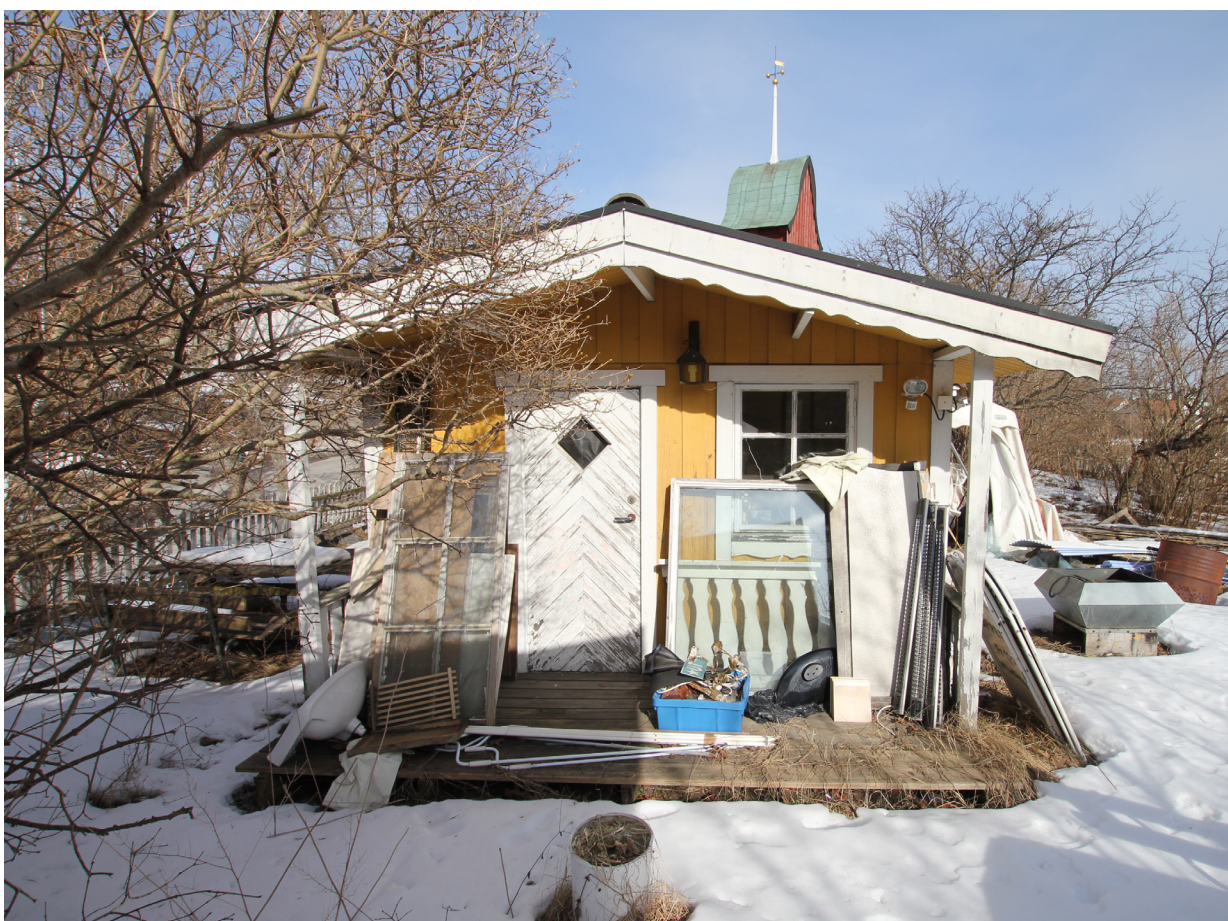
ÖVERSIKT, FRIGGEBODEN MOT NORR
