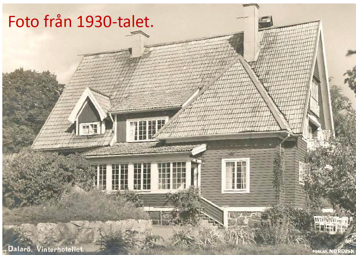
BYGGNADEN PÅ 1930-TALET. DALARÖ HEMBYGDSFÖRENING
