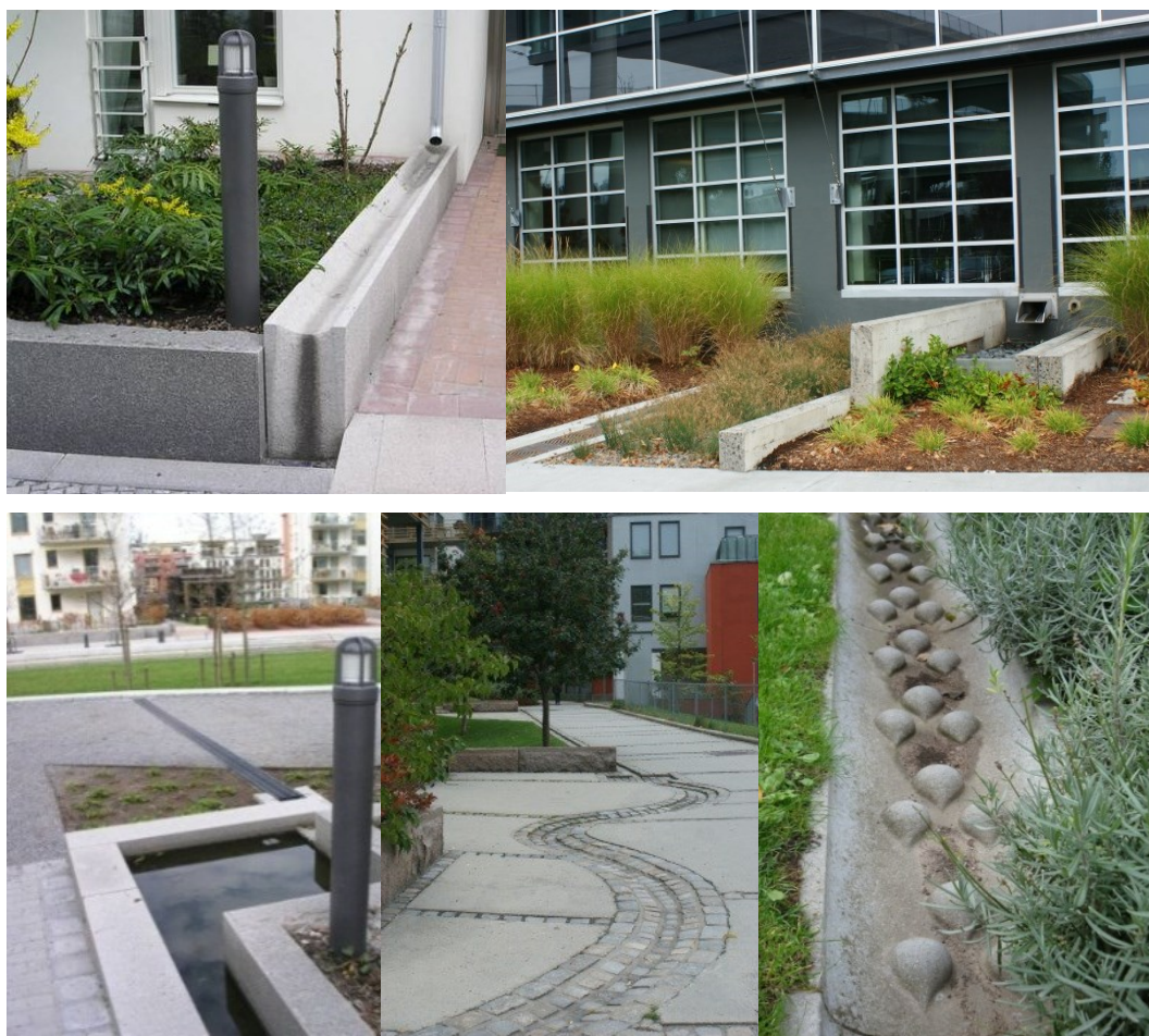
Figur 7. Övre bilderna ger exempel på stuprörutkastare som ansluter till rännor. Nedre bilderna visar olika typer av rännor.
