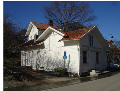
Grannhus mot nordväst.
