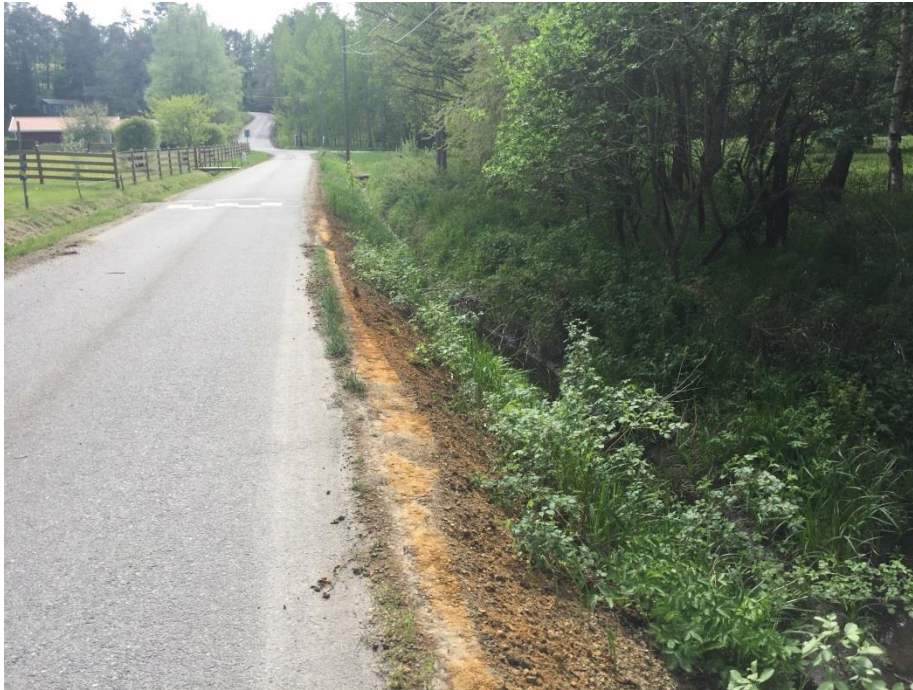
Figur 8. Dike längs med Kolbottenvägen där underhåll nyligen utförts längs med väggkanten. Bild från platsbesök 2018-05-21.
