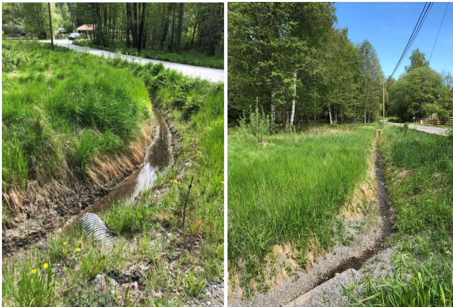
Figur 7. T.v. Dike och vägtrumma beläget i korsningen mellan Jaktstigen och Kattviksvägen. T.h. Dike längs Kolbottenvägen taget från korsningen med Kattviksvägen. Foton tagna under platsbesök 2018-05-21.
