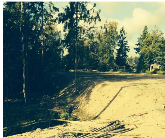
Markuppfyllning som inte anpassats till angränsande mark.
