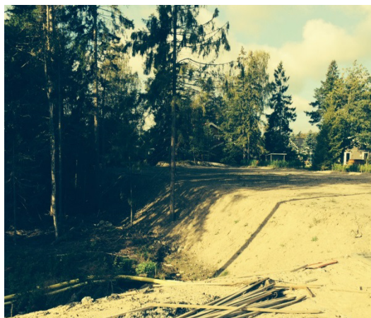
Markuppfyllning som inte anpassats till angränsande mark.
