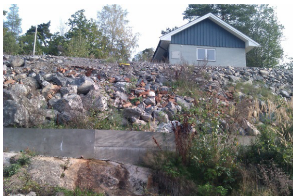
Allt för stora mängder med fyllnadsmassor mot väg
