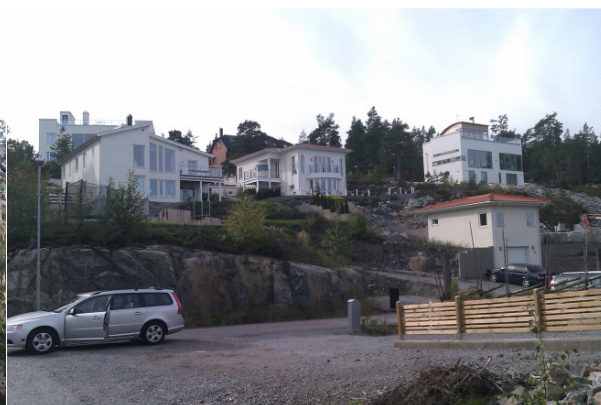
Sprängning samt fyllnader för att skapa utsikt och anlägga gräsmattor innebär stora ingrepp i befintlig miljö.
