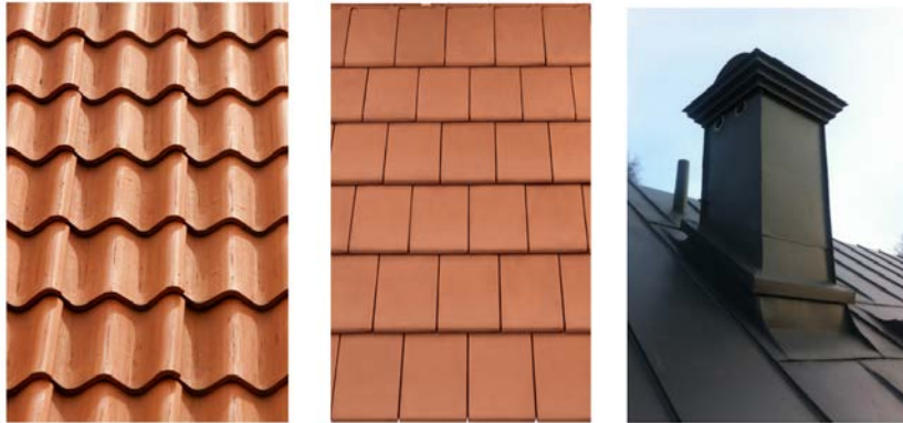
Exempel på utförande av lertegelpannor, samt falsat plåttak, ur kvalitetsprogram Dalarö strand.
