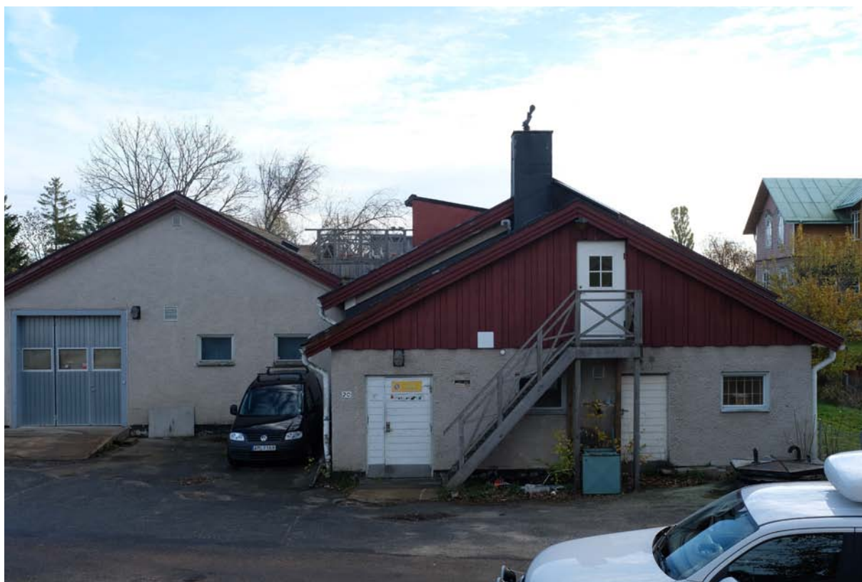
Telestationens fasad mot Sagavägen. Den högra delen har förmodligen inte haft gavelpanel tidigare, troligen är även trappan sekundär.
