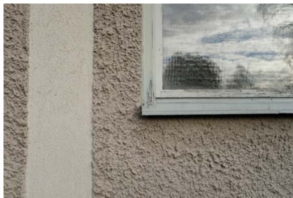
Detalj av telestationens fasad. Fönstren har träbågar och karmar och är ursprungliga, putsen består av spritputs med släta partier. Spritputsen har krossad spritsen, vilket kan tyda på att den är sekundär.
