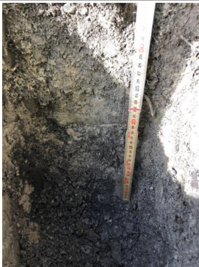
Figur 5. En av de provgropar som grävdes vid platsbesöket på totalt cirka 0,4 meter. Bilden visar en ökning av blött, mörkare material vid botten av gropen.
