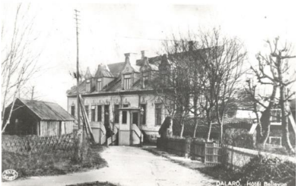
Figur 5. Hotellbyggnaden sedd från väst. Ursprunglig entré syns (bild från Haningearkivet, okänt datum).
