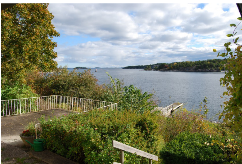
Terrassen ovanpå jordkällaren består av en gjuten betongplatta med staket av vitmålat smide.
