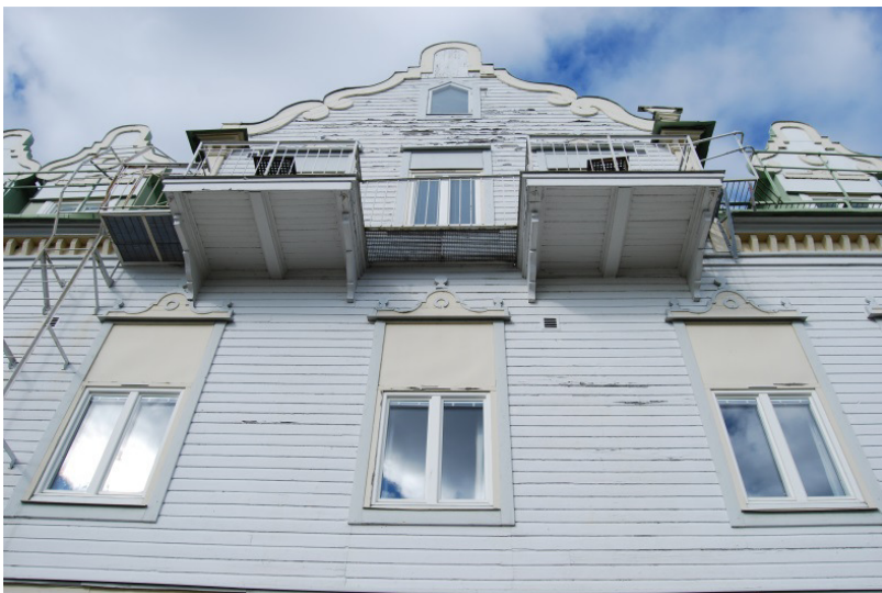
Sjösidan sedd från terrassen med två av fyra balkonger.
