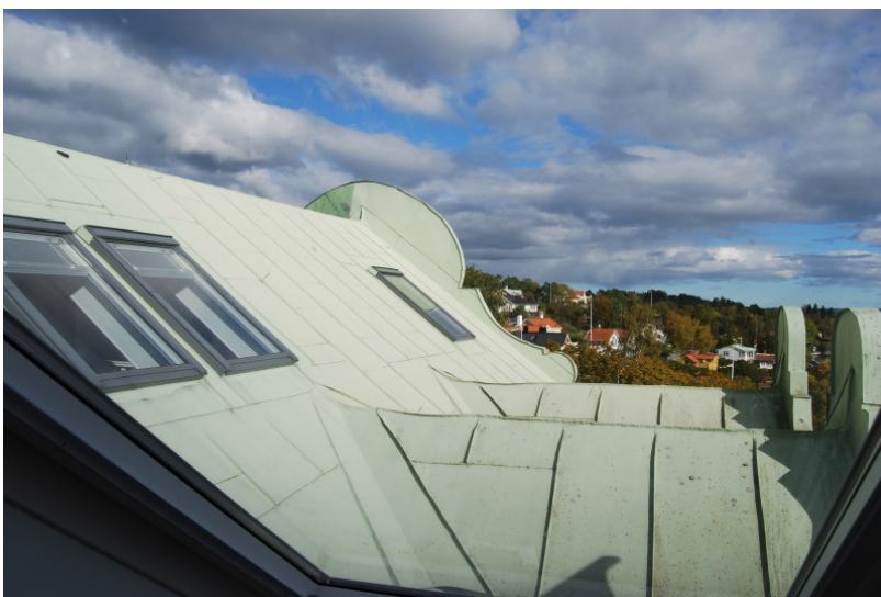
Taket sett från övre vinden.
