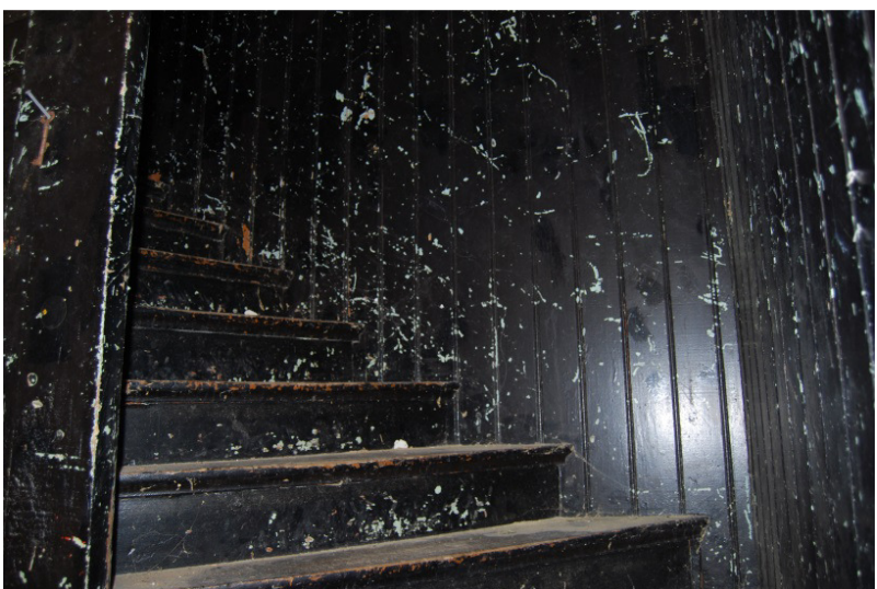
Rummet ovan nås via en trätrappa med väggar klädda med pärlspontpanel.
