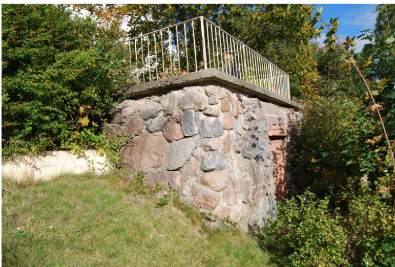
Jordkällaren vid stugan med en terrass till tak.
