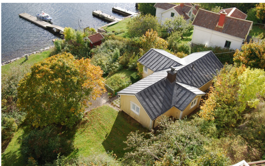
Stugan 2015 sedd uppifrån huvudbyggnadens vind.
