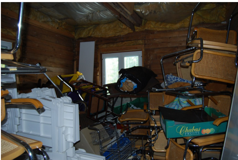
Utrymme under terrassen på östra gaveln.
