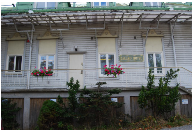
Lastkajen från 1950-talet utmed hotellets entrésida. Köksingången och skärmtaket.
