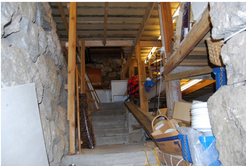
Trappan inne i källaren är överbyggd med ett loft.
