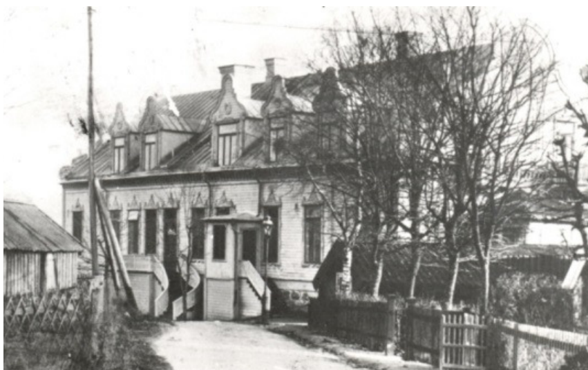
Bellevue, norra fasaden. Byggnadens båda ursprungliga entréer framgår av bilden. Den främre med en liten förstuga är en köksingången och den bortre, är huvudingång med en svängd trappa. Okänt datum, från Haningearkivet, Haninge kommun, bildnr 3380
