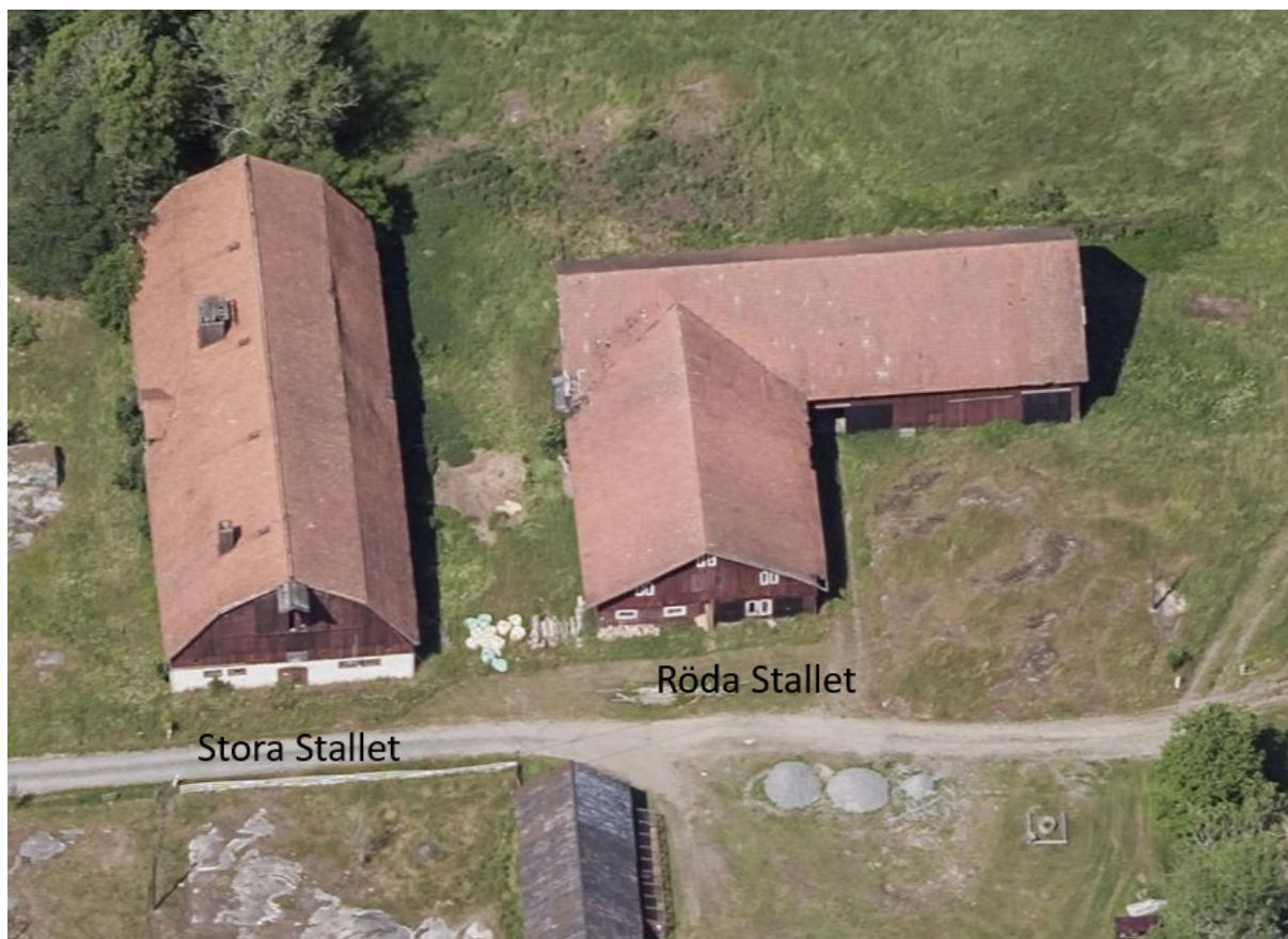
Figur 20. Översiktsbild Stora stallet och Röda stallet
