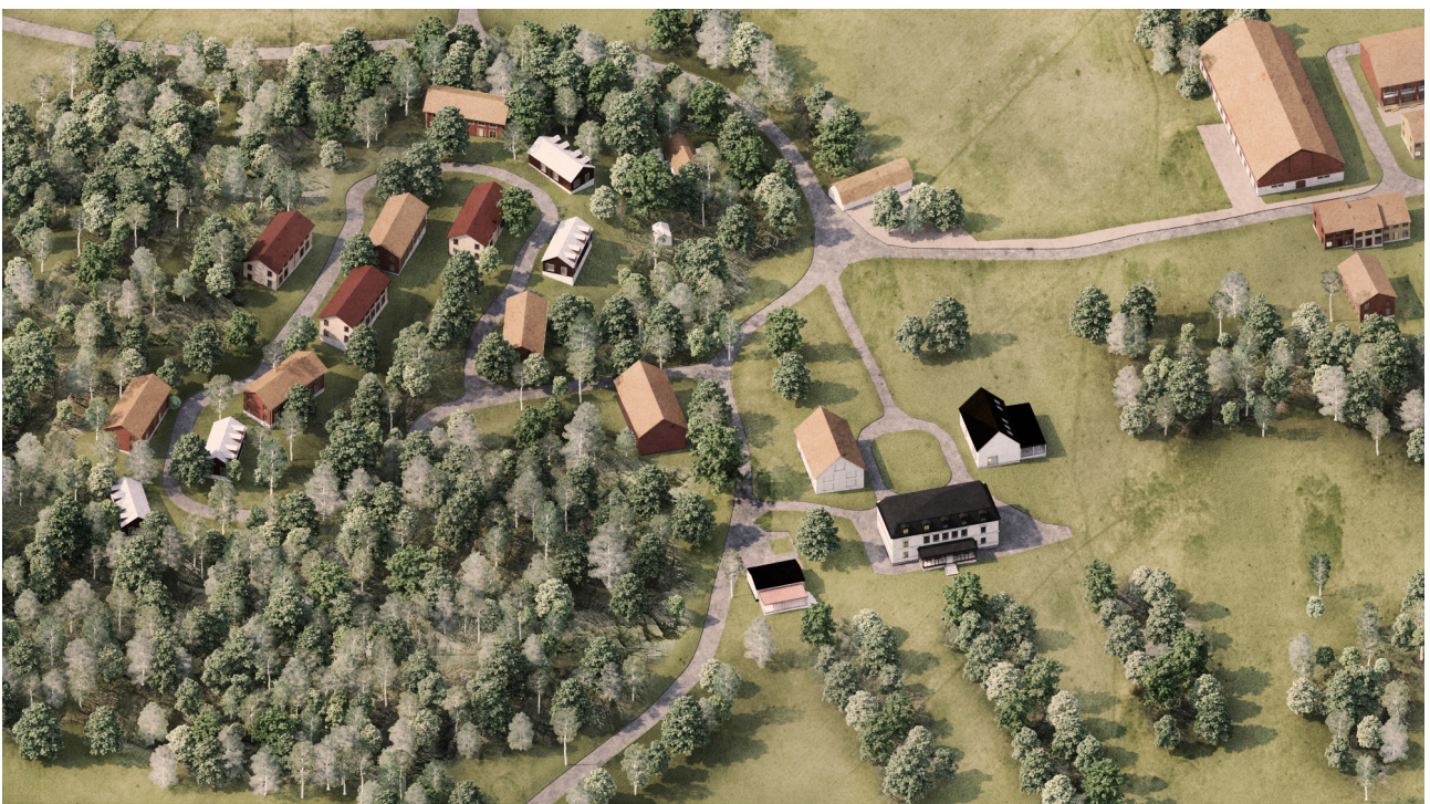
Flygvy över bebyggelsen i Skogsbrynet, Arbottna Säteri samt de två flygelbyggnaderna.
