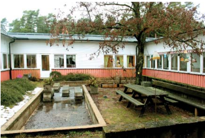
Västra innergården. Påkostad gestaltning med en nedsänkt L-formad betongdamm som svarar mot den L-formade mur som omger bänkarna. Idag pågår odling på gården under sommarhalvåret.
