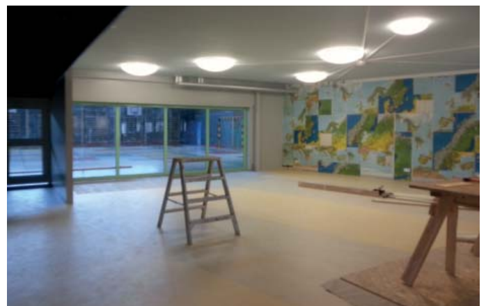
F.d. skolbyggnad i Hovsjö under renoveringen.
