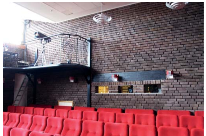
Aulan som domineras av väggar i brunt tegel med djupt liggande fogar. De nätta röda plåtarmaturena längs väggarna är ursprungliga.
