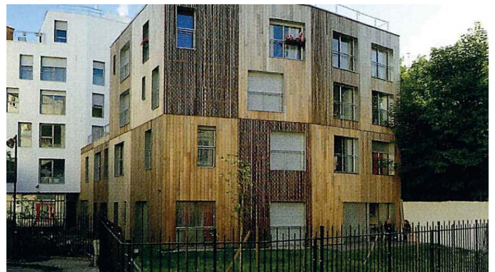
Bostadshus i trä, SOA Architectes
