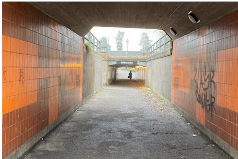
Södra gångtunneln. Fotograf: Norconsult/ET.
