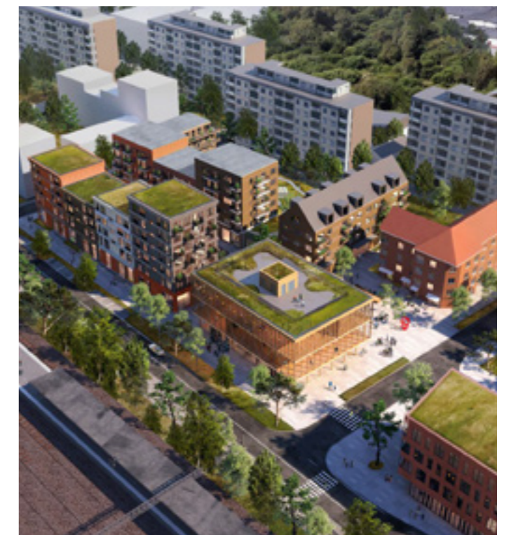
Kulör- och materialpaletten knyter an till det föreslagna för bygghuset i Kvalitetsprogram Jordbro Etapp 2. Bild: Kaminsky Arkitektur
