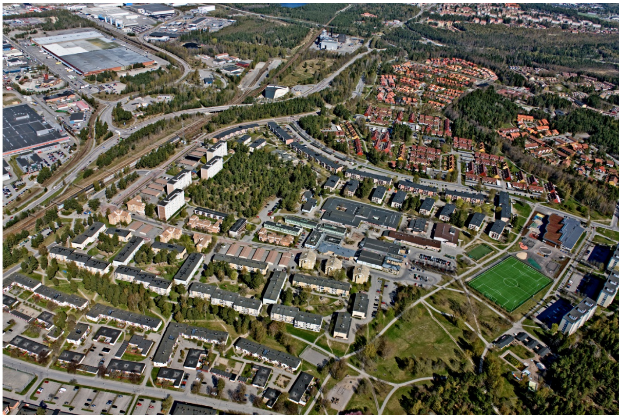
Figur 4. Snedbild över centrala Jordbro, tagen från sydost (Haninge kommun, 2014).
