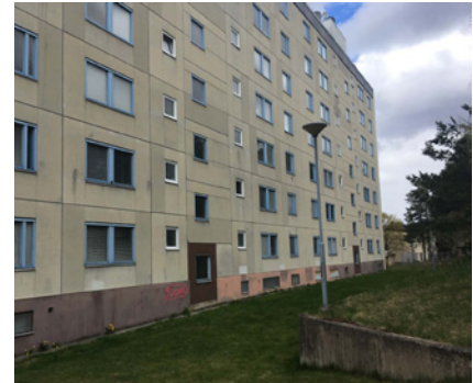
Fig. 27: De höga husen längs Södra Jordbrovägen har sin baksida mot Hurtigs park.
