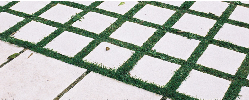
Med en gräsarmerad platsättning ökar infiltrationen
