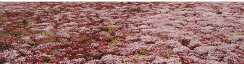
Gröna tak fördröjer dagvatten och är inte alltid gröna till kulören
