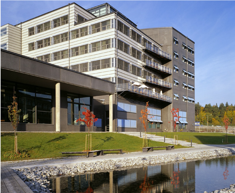
Byggnaden minskas visuellt genom skilda material och tydlig volymbehandling
