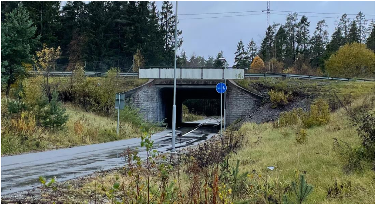
Figur 15: Gång-och cykeltunnel under Nynäsvägen, från Albyberg till Jordbro.
