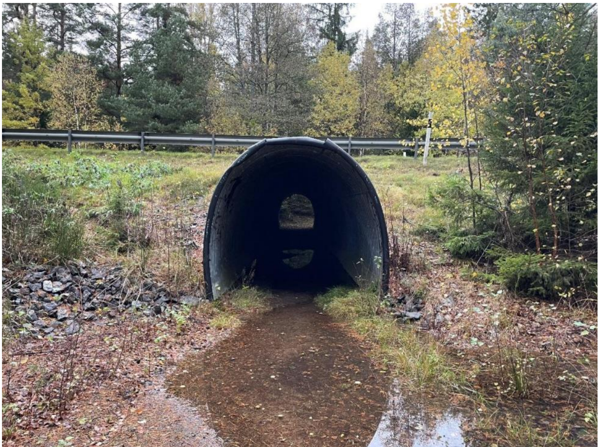
Figur 16: Gång-och cykeltunnel under Dalarövägen, från Albyberg. Efter denna tunnel tar cykelvägen slut. Planer finns dock på att förlänga cykelstråket bort till Brandbergen.
