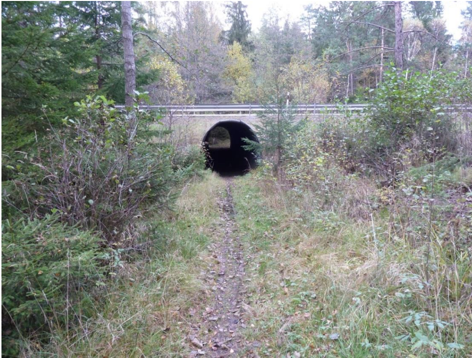
Figur 21. Nuvarande mycket liten och trång gångtunnel under Dalarölänken sammanbinder det gröna stråket mellan etapp 1 och 2 med skogarna nordost om området.
