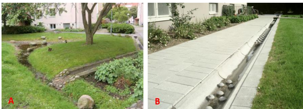
Figur 25. Exempelbilder på hur olika stråk anpassade till mer eller mindre hårdgjorda miljöer kan se ut. A: Grön innergård med ett hårdgjort stråk som leder dagvattnet till ett öppet avrinningsstråk i Augustenborg. Bilden är tagen av Anette Björlin. B: En hårdgjord lökränna. Avleder dagvattnet kontrollerat och med ökad självrensning i och med lökarna. Lökarna ger god självrens även vid låga flöden. Bilden är från S:t Eriks.
