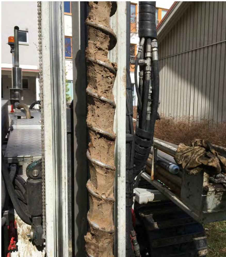
Figur 6. Söderbymalm. Skruv med material, cirka en meter långt, vid borrhpunkt 5. Materialet är finsand.
