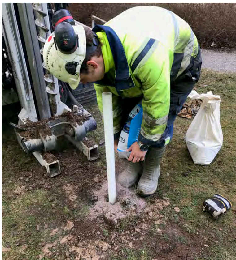
Figur 8. Söderbymalm. Tätning av grundvattenrör med sand och bentonit.
