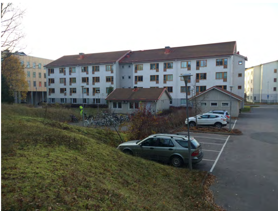
Figur 2. Söderbymalm. Cykelparkeringen som även syns i figur 1 samt del av bilparkeringen och infart till höger i bild.
