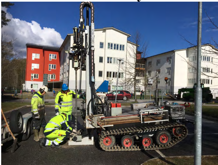
Provtagning av jord med borrhvagn på fastigheten Söderbymalm 3:273.
