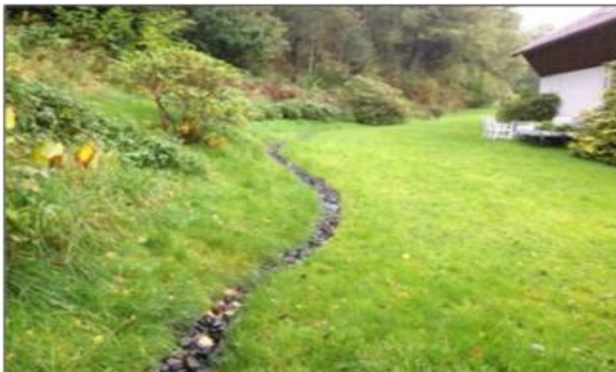
Figur 7-2 Litet uppsamlande svackdike med makadambotten.
