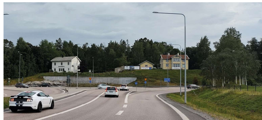
Foto från norr, Gudöbroleden (ögonhöjd från personbil) mot befintlig fastighet.
