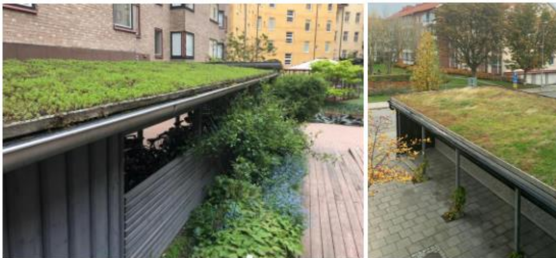
Figur 14. Exempelbilder på skärmtak med växtlighet. Vid tillfällen då växtligheten och jorden är mättad samlas vatten upp i hängränna. Foton tagna av Bjerking AB.
