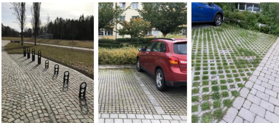
Figur 15. Exempel på genomsläppliga beläggningar i urban miljö. Foton: Bjerking AB.
