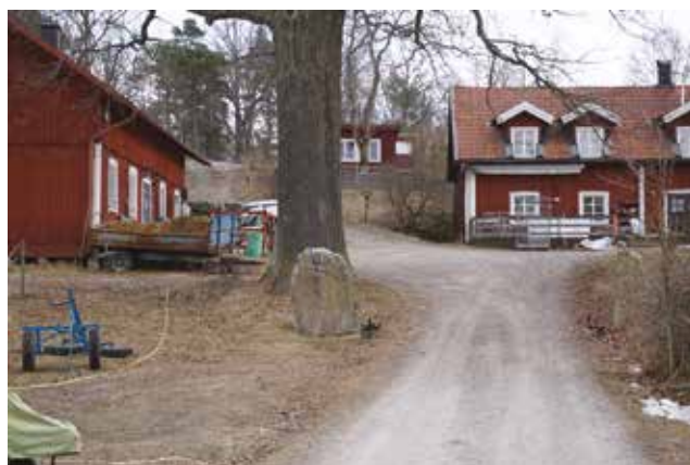
Överste: Manbyggnaden på Fors 1, kallad "Herrgården", skiljer sig markant från övrig bebyggelse med sina putsade fasader och 1930-tals utförande. Nederst: På bilden syns stallet till vänster, "magasinet" till höger och emellan dessa runstenen framför trädet. Foto: Tobias Mårud.
