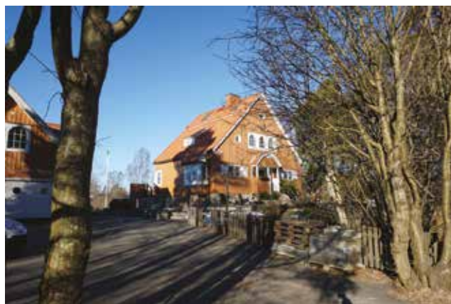
På en liten höjd något skymd av en trädridå och indragen från Nynäsvägen ligger Villa Utansjö, en av Västerhaninges arkitektoniskt mest intressanta byggnader. Foto: Tobias Mårud.
