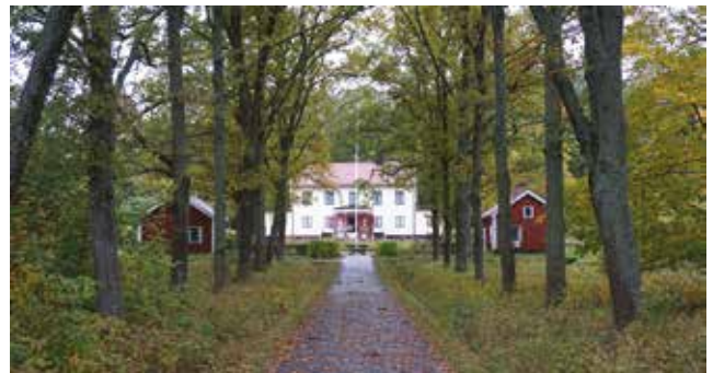
Huvudbyggnaden och flyglarna på Hammar (Hammar 1:12). Foto: Tobias Mårud
